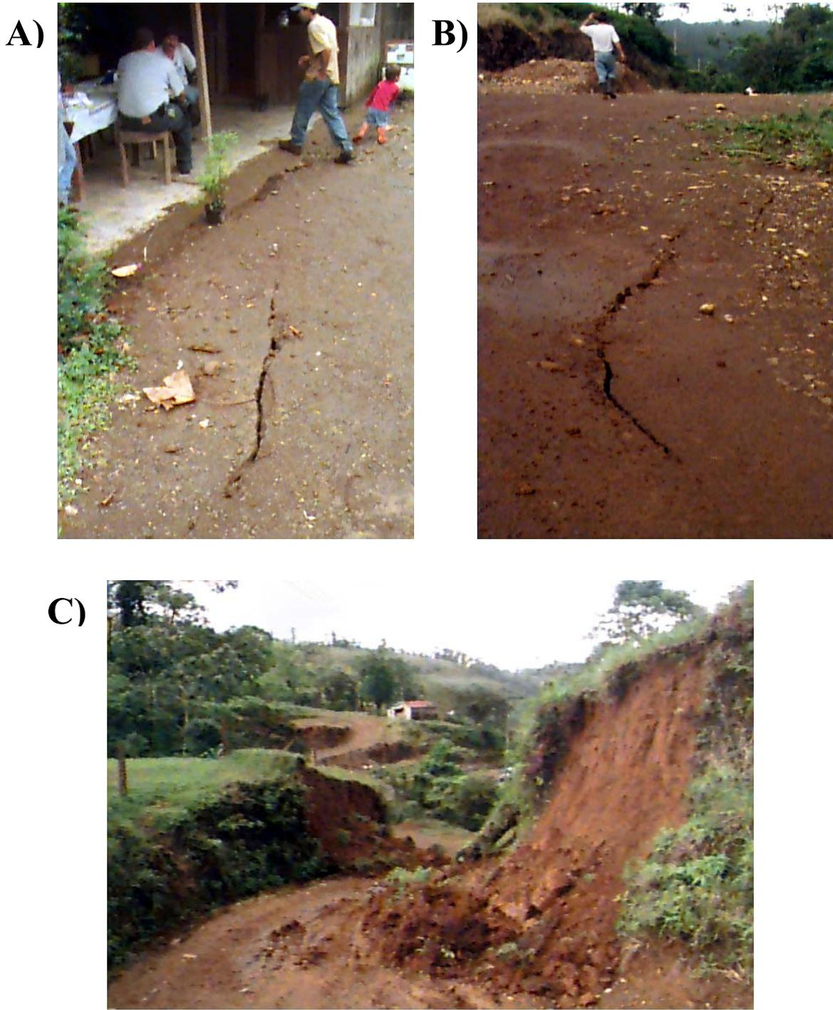
**Figura 3:** Efectos geológicos debido al sismo de Bijagua en la zona de El Pílon de Upala. **A) y B)** Pequeñas grietas formadas por asentamiento diferencial en el camino de El Pílon. **C).** Deslizamientos en el camino de acceso a El Pílon.
