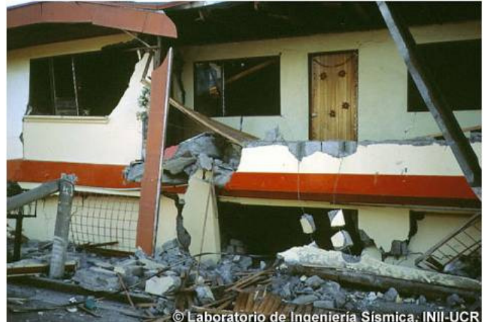
a) Fotografías de estructuras dañadas debido al terremoto de Alajuela (22/12/90). Corresponden a grado de daño 3 (foto izquierda) y grado 5 (foto derecha)
