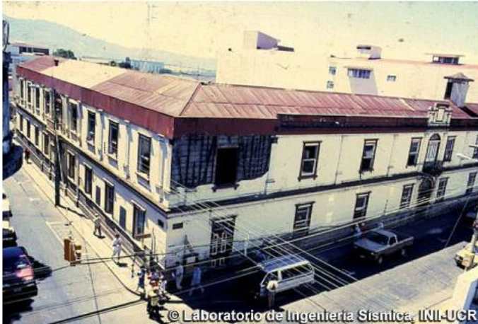
a) Fotografías de estructuras dañadas debido al terremoto de Alajuela (22/12/90). Corresponden a grado de daño 3 (foto izquierda) y grado 5 (foto derecha)
