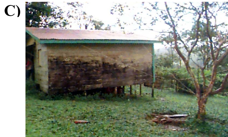
Figura 2: Daños en estructuras en la zona de El Pilón de Upala. A) y B) Casas con severos daños en sus bases debido a la ausencia de arriostres (en equis) y al mal estado de la madera. C) Casa amarrada con mecates a los árboles como medida implementada por los vecinos para evitar el colapso temporal luego del sismo. D) Daños en un estanque de tilapias.
