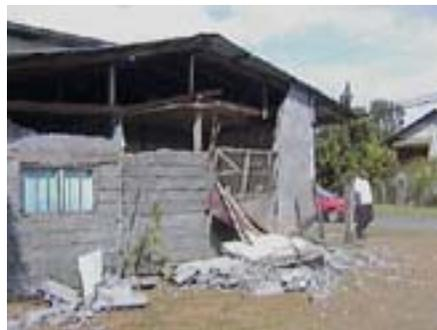
Colapso de muros en varias viviendas de San Vicente de Puerto Armuelles, debido a la ausencia de refuerzo (carillas de acero horizontales y verticales), así como a una mala concepción de este sistema constructivo.
