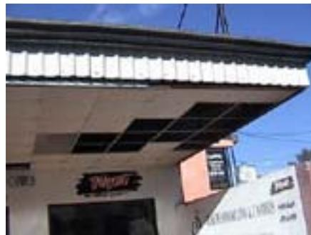
Daños en estructuras localizadas en el centro de Ciudad Nelly. En la figura de la izquierda se observa el desprendimiento del repello de las paredes, aún cuando la estructura de mampostería parece estar en buen estado. En la figura de la derecha se aprecia que algunas láminas del cielorraso se desprendieron de la suspensión de aluminio que las soportaba.
