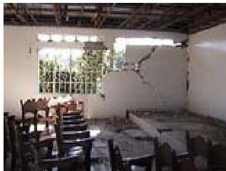
Daños en el Templo de los testigos de Jehová, en Agua Buena de Coto Brus. Se observa la ausencia del refuerzo (varillas de acero), lo que produjo el colapso total de la pared formada por bloques.
